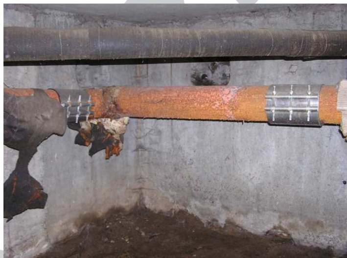
Fig.1. Retele publice ce traverseaza subsolurile blocurilor corodate, reparate punctual de ANB (cu mansoane) si cu intarzieri care au generat petitii justificate ale utilizatorilor (Blocul Rahova 5 iunie 2005).
